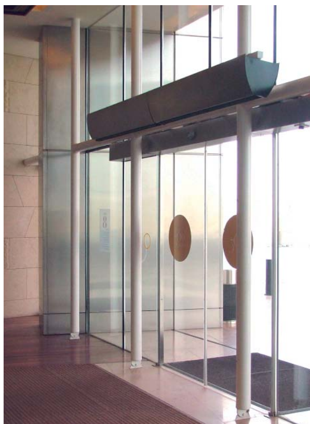
Dvě clony lze nainstalovat vedle sebe s pomocí spojovací sady a vytvořit tak elegantní řešení pokrytí širších dveřních otvorů
